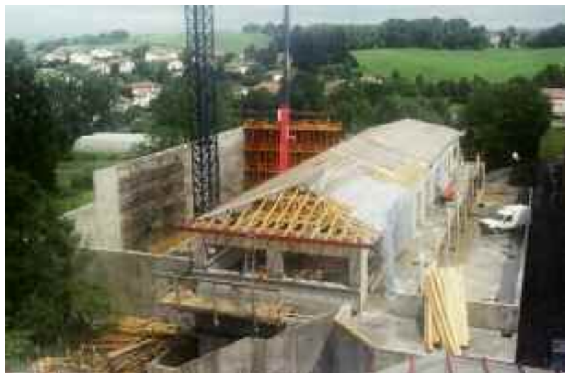
1999 : Construction d'une salle polyvalente de sports collectifs et de pelote, salles de cours et de laboratoires.
